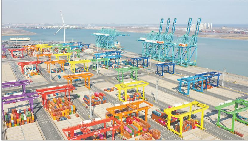
作为京津冀“海上门户”,天津港不断推进智慧港口建设,为京津冀协同发展持续注入新动能。今年1月,天津港建成物联网集装箱码头。该码头由此前建成运营的智慧零碳码头升级而来,共安装10万多个各类传感器,覆盖生产设备、能源管理、楼宇智控、园区辅助等方面。依托5G全网互联,结合“大数据中心+边缘计算”,算力达到传统码头的5倍以上。
