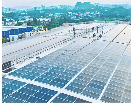
近日,中南钢铁中南股份炼铁厂B型原料大棚光伏项目完成首个阶段设备安装。中南股份厂区光伏发电合作项目采用国内最新光伏技术,可为企业节约外购电成本,减少碳排放,助力能源结构转型。炼铁厂B型原料大棚是弧形屋顶建筑,可利用光伏发电屋顶面积10万平方米,在阳光充足的条件下,每月可产生120万千瓦时清洁能源。
