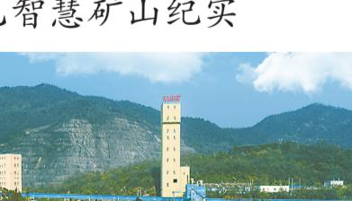
法具有安全可靠性高、矿石损失贫化率低、回采率高的优点,同时能最大程度避免发生地表塌陷等地质灾害。目前,大冶矿所有的尾砂均用于井下充填,真正实现无尾矿山。
