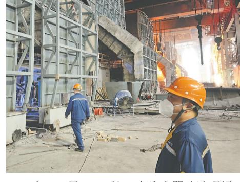
在1-2号AOD炉一次除尘器改造现场，项目经理涂传进的工服早已被汗水浸透，安全帽下的脸庞被晒得通红，但他手中的图纸和检查表却从未放下。“除尘器焊缝的密封性必须百分百达标，否则粉尘泄漏会影响整个系统的排放指标。”涂传进一边用沙哑的声音叮嘱施工人员，一边弯腰钻进狭窄的设备夹层。高温让金属表面烫得难以触碰，但他仍坚持用手电筒一寸寸检查焊缝质量。
