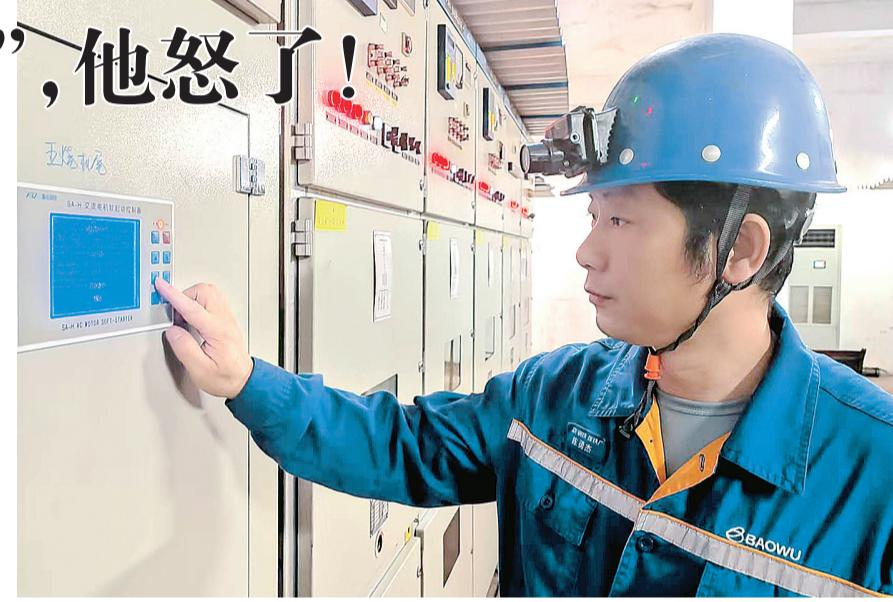
备升级改造中，供货厂家安装的新配电柜存在走线不规范问题，对方承诺不影响使用，他却直接拒绝验收：“今天放过小毛病，明天就可能出大事故！”他带领团队连续三天重新布线，硬是将复杂的线路梳理得井井有条，连厂家工程师都竖起大拇指：“从没见过这么较真的电
