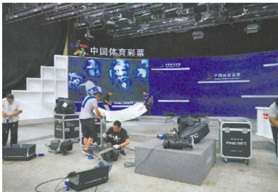
8月1日,拆除原舞台
