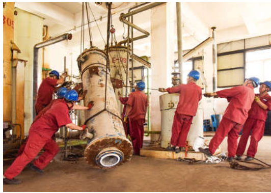
有布置、有落实。修建公司检修一车间严格遵守安全规程,认真执行安全“八证”制度,坚决制止一切不安全因素的发生,为公司下半年生产安全稳定运行提供坚实保障。图为氯化苯装置安全检修现场。杨宇文/摄
