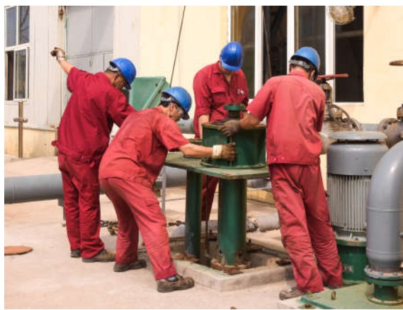
氯碱厂保运组与各生产车间紧密配合加强装置设备日常维护保养发现问题随到随修。近日保运组对12M车间循环水地坑泵进行设备消缺，为确保离子膜装置安全稳定运行提供坚实的保障。图为设备消缺现场。
