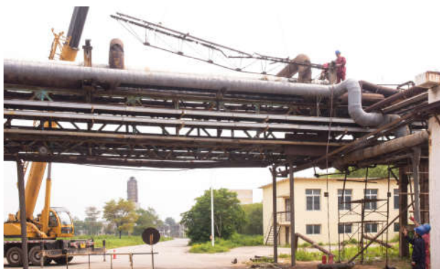
本着对安全隐患发现一处，消除一处的原则，近日，修建公司检修二车间按计划对氯乙烯车间干道上方部分废弃的桁架进行拆除，有效保证了过往行人及生产的安全，为氯乙烯装置平稳运行提供安全保障。图为拆除现场。 杨宇文/摄
