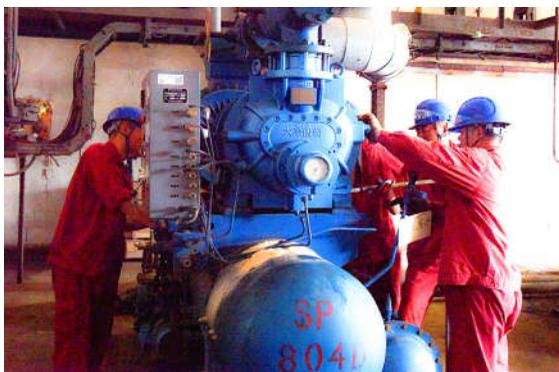
聚醚厂四万吨聚醚车间强化设备管理，加大对重点设备的检查维护。8月7日，该车间在保运组检修人员配合下，对D台冷冻机进行消缺，确保环氧丙烷装置安全稳定运行。图为设备消缺现场。
