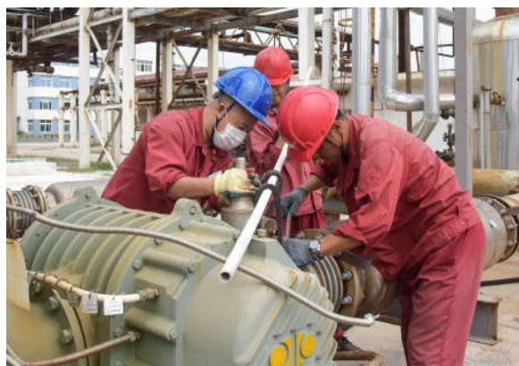
在8月份生产中,聚醚厂SPO车间严抓设备管理工作,认真做好转动设备的维护保养,发现问题,及时消除,为确保生产的连续稳定运行打下坚实的基础。图为车间正在对罗茨风机进行技术消缺。
