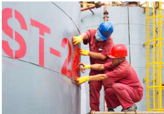
为加强作业现场危险辨识, 聚醚厂组织人员对危化品罐区的罐体进行除锈刷漆, 并对粉刷后的罐体喷涂上醒目的标识, 切实加强了作业现场的安全管理。图为作业现场。 杨宇文/摄
