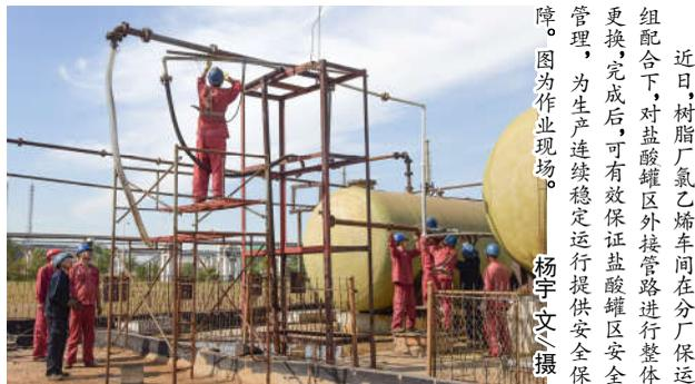
近日，树脂厂氯乙烷车间在分厂保证配合下，对盐酸罐区外接管路进行整体更换，完成后，可有效保证盐酸罐区安全管理，为生产连续稳定运行提供安全保障。图为作业现场。杨宇文摄
