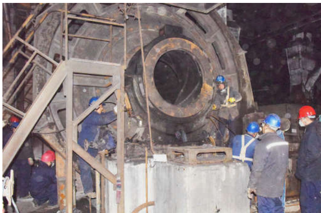
为了给公司四季度生产提供坚实的公用工程保障,近日,公司相关部门人员与热电厂、修建公司等专业检修人员联合“大会战”,对热电厂重点设备进行维护、检修,确保设备安全连续稳定。图为4#锅炉球磨机检修现场。杨宇文/摄
