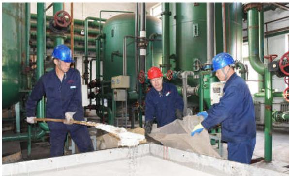
12月19日，热电厂供水车间组织人员按计划对除盐水系统阴 7# 离子交换器的水帽进行拆卸清洗，同时对惰性树脂与阴离子树脂进行分离。此项工作的完成，将极大保证周期产水量，降低能源消耗，保证除盐水系统安全稳定经济运行打下坚实基础。
