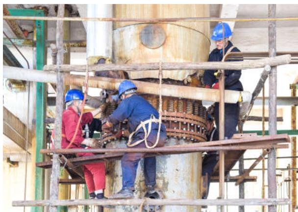
近日，氯碱厂十二万吨离子膜车间对三合一炉A炉进行拆解维护，三合一炉是生产高纯酸的主要装置，经过长时间的连续运行，石墨节孔壁上钙镁离子结垢严重，导致酸温偏高，换热效果不理想，影响酸产量。在车间和保运组密切配合下，对其进行了彻底清理维护，为生产的安全稳定运行提供设备保障。
