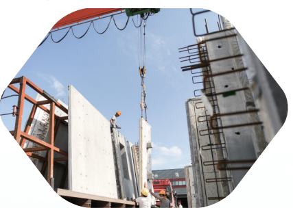
汝州市东江建筑工业科技有限公司混凝土预制构件外运郑州
