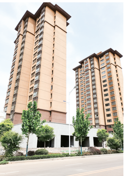
安置房拔地而起 梁鹏浩摄
