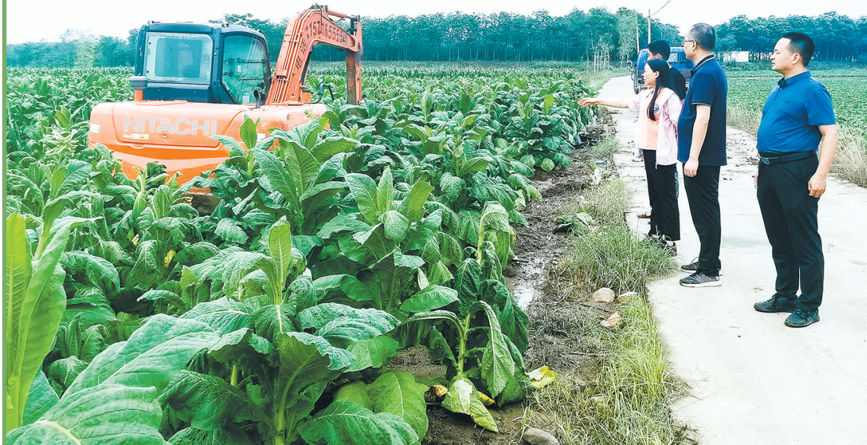
7月26日,汝州市烟草专卖局防汛突击队深入烟叶生产一线,协助烟农开挖挖渠、清淤排水,开展生产自救。在灾情排查中,该局发现有139户烟农、1979亩烟田遭受损失。面对严峻形势,该局党组紧急集结防汛突击队,调集8台挖掘机、13台水泵,挖排水沟2153米,帮助烟农恢复生产。
