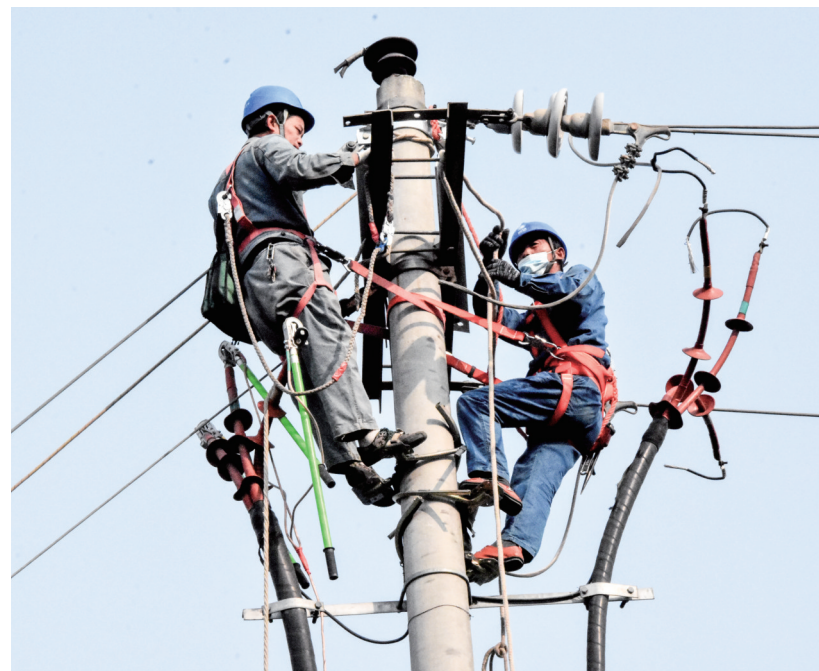
11月16日,国网平舆县供电公司组织人员扎实推进2021年第三批配网工程改造项目建设,提升配网供电可靠性,为城区用户的冬季可靠供电提供坚强的保障。 闫梦珂 摄
