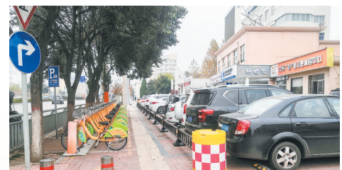
车位阻车器安装后 王丹涛摄
