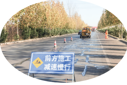
应急中心处理路面缝隙 张应霞 摄
