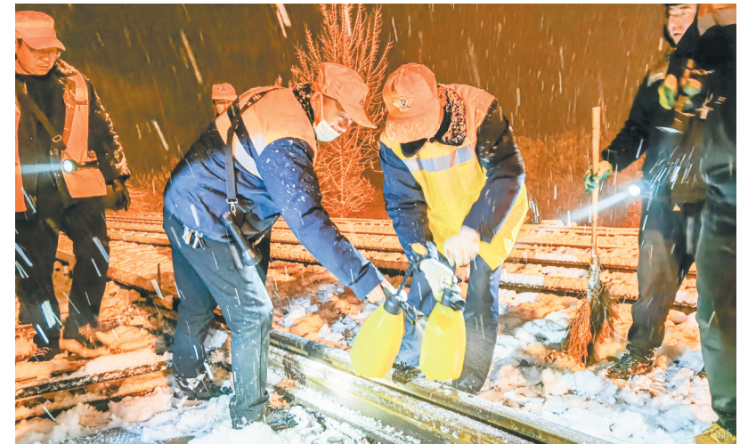
1月4日,河南多地遭遇大雪降温天气,中国铁路郑州局集团有限公司“以雪为令”,全面启动应急预案,及时清除冰雪,加强设备检修,确保旅客平安出行和铁路线路畅通。图为铁路职工正在对道岔进行除雪作业。 本报记者 李朝亿 通讯员 郑轩 摄
