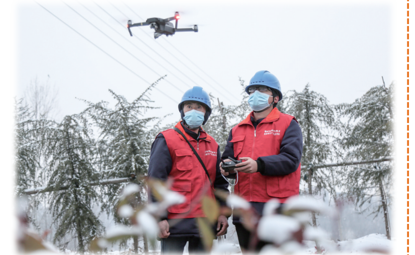
1月21日，汝阳县境内普降大雪。汝阳县供电公司组织党员服务队利用无人机对35千伏及以上输电线路、设备进行全方位巡视检查，确保电网安全稳定运行。
