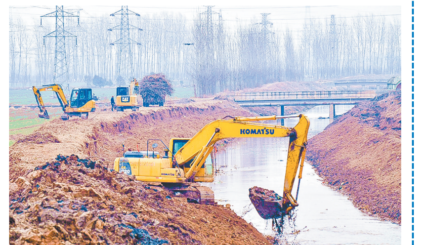
2月9日, 沁阳市安全河西向镇段, 挖掘机正在清理淤积、加高河堤。去年7月, 安全河堤防破坏严重, 造成两岸庄稼受淹, 部分村庄进水。为保障群众生命财产安全, 该市筹措300余万元, 实施清淤疏浚整治工程, 目前已完成七成以上。 本报记者 杨远高 通讯员 杨帆 摄
