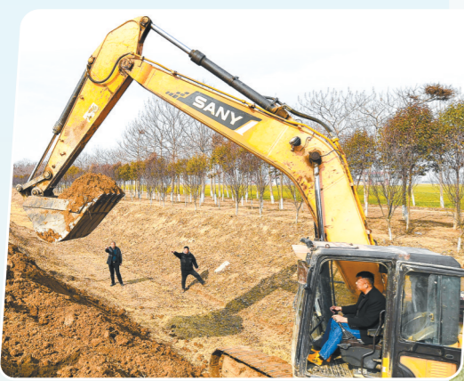
2月16日,兰考县考城镇组织机械进行河道清淤,助力春耕生产。目前已清淤开挖河道6条34400米,有效提升2万多亩农田灌溉条件。 杨远高 樊雨晨 摄
