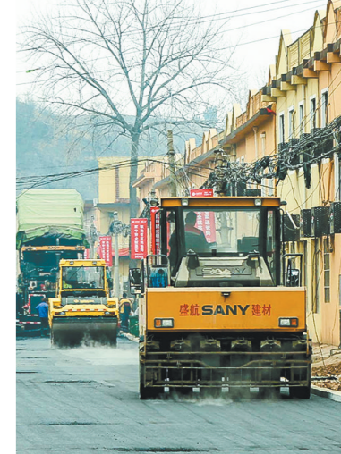
2月21日,汝阳县柏树乡,施工人员在汝洛路柏树段铺设沥青,改善群众出行条件,加快和美乡村建设。 康红军 摄
