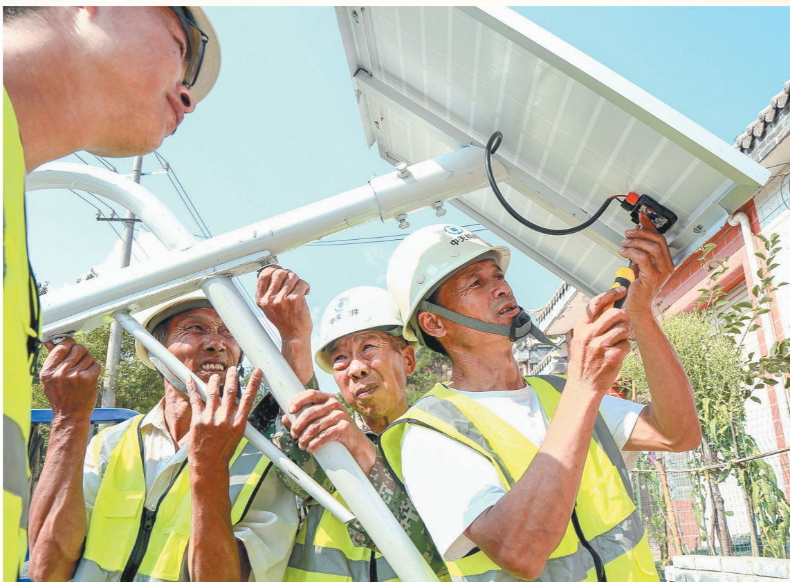
7月18日,汝阳县十八盘乡木庄村,工人在安装太阳能路灯。该村在驻村帮扶单位的支持下投入35万元,实施了路灯安装、饮水工程延伸、道路加宽、水库维护等工程,加快和美乡村建设步伐。 康红军 摄
