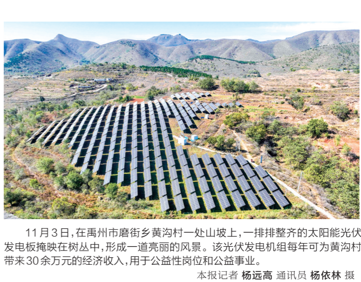
11月3日，在禹州市磨街乡黄沟村一处山坡上，一排排整齐的太阳能光伏发电板掩映在树丛中，形成一道亮丽的风景。
