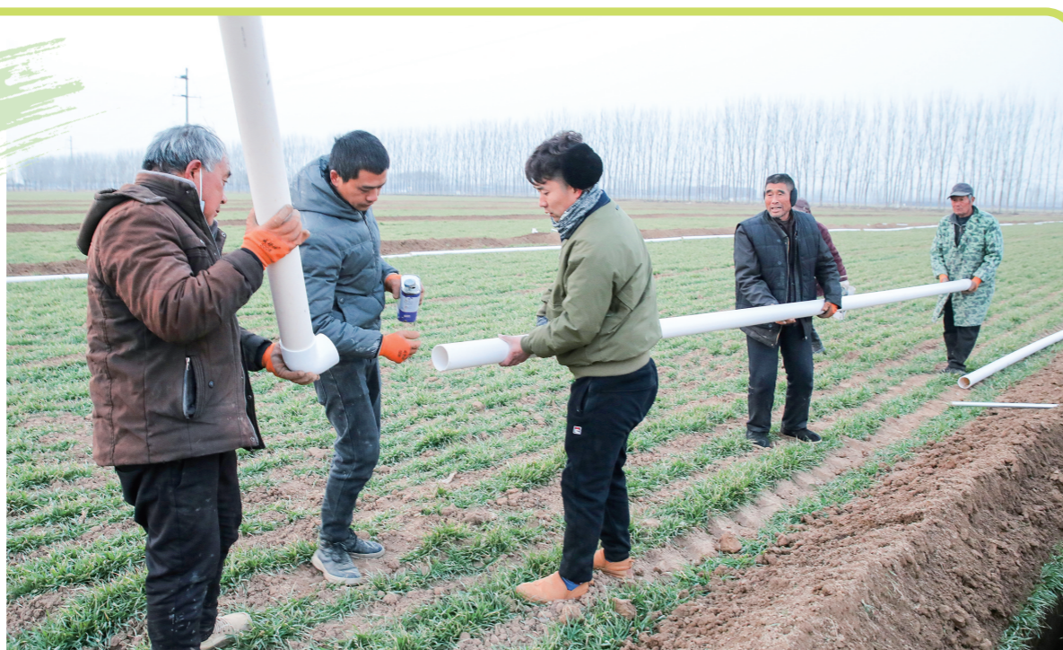
1月14日，在尉氏县张市镇石潭村高标准农田水利项目施工现场，农田灌溉设施正在施工。连日来，尉氏县有序开展平整土地、修建水渠、铺设机耕道，促进农业产业结构转型升级，为农业丰产丰收奠定良好的基础。李新义 摄
