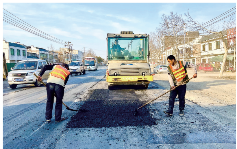
1月28日，邓州市公路事业发展中心职工对G207路段路面病害进行处治。连日来，邓州市公路事业发展中心抢抓晴好天气，积极组织人力、物力，对辖区内的管养公路实施路面病害集中处治工作，及时消除安全隐患，确保春运期间公路安全畅通。
