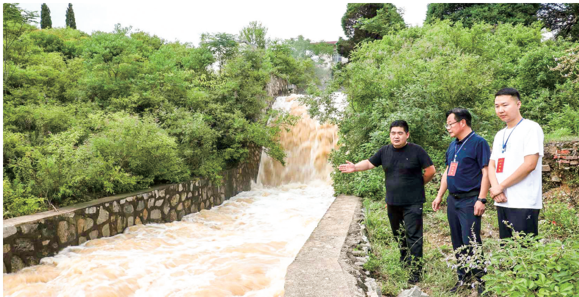
7月8日,确山县纪委监委第三协作区纪检监察干部走进竹沟水库、龙山水库等防汛重点单位,详细了解防汛工作方案、应急预案、物资储备情况,并对风险隐患再排查、重点部位再加固等进行监督检查。 本报记者 黄华 通讯员 王倩 摄
