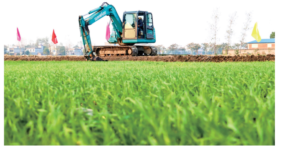
11月7日,郑州市龙堰乡唐坡村,挖掘机在清理沟渠内的杂草、垃圾杂物、淤泥等沉积物,通过平整边沟、加固边坡,疏通田间地头的斗渠、农渠,从而打通农田排涝抗旱的“毛细血管”。 王小军 摄
