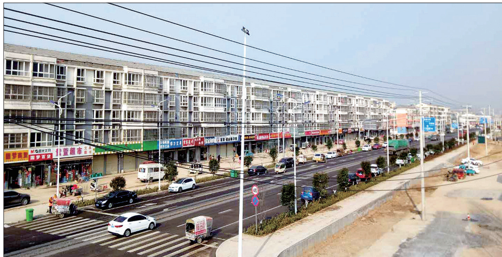
近两年来,经开区积极实施交通惠民工程,补齐农村公路短板,大力新建、扩建道路,确保了百姓出行路路通。新路网成为实施乡村振兴战略的开路先锋。图为徐庄镇新扩建的6车道紫房路。
