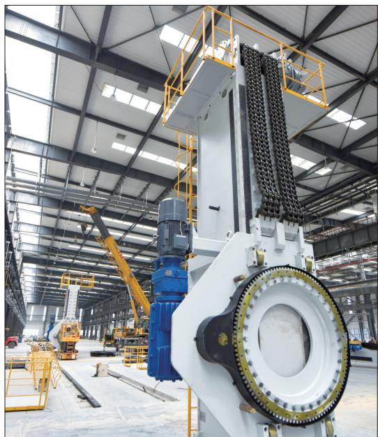
日前，记者了解到，徐州可力斯工程机械项目进展顺利，相关设备的引进安装正在全力进行，预计六月底投产。图为该项目大型焊接生产线（焊接机器人）、激光切割、数控冲床等先进设备安装调试现场。
