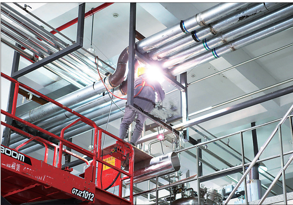
7月8日,投资20亿元的徐州芯思杰封测项目的制冷车间,工人们正在紧张地安装电机、管道、制冷设备等,确保7月底5G高端光芯片封测设备顺利试车。
