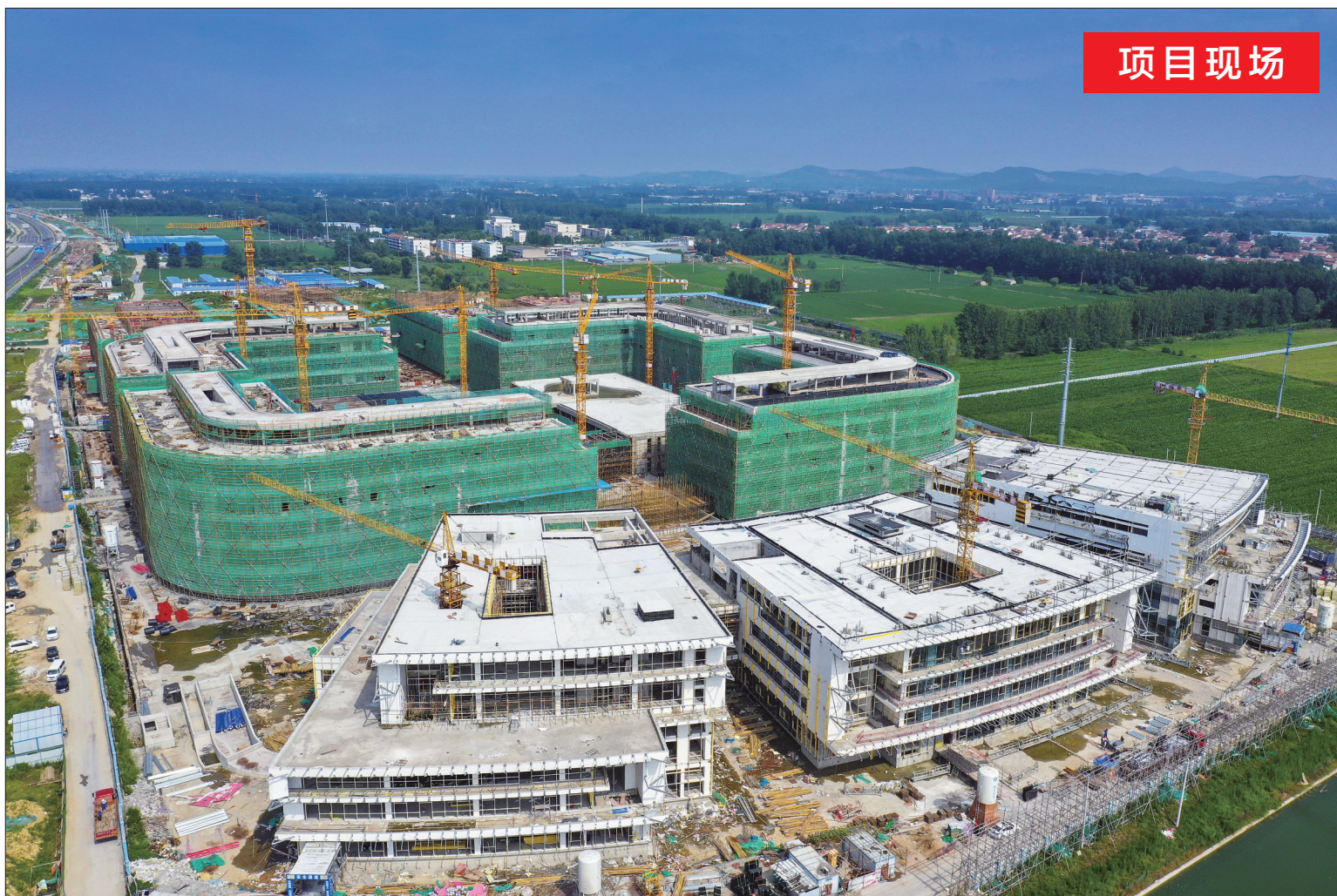
东湖医学创新港建设加速推进,即将全面封顶。
