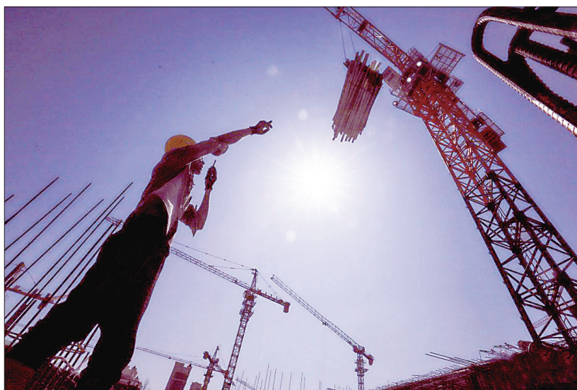
8月13日,金龙湖创新谷(二期)项目工地上,工人们冒着高温酷暑,在烈日下挥汗如雨加紧施工。
