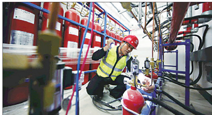
中秋国庆双节来临之际,应急管理局会同职能部门联合镇(街)对辖区运输、涂装等企业进行摸排整治,集中防范重大事故隐患。图为相关技术人员深入金仕达机械公司进行安检。
