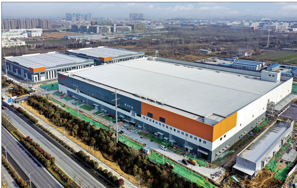
今年以来,银科5G智能终端生产基地智能项目推进迅速。目前,外立面装修已完成,内部装修及设备安装正在紧锣密鼓进行。
