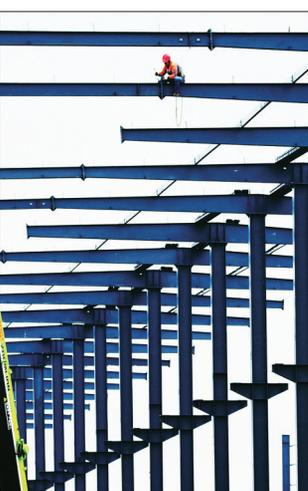
骄阳似火，热浪袭人。金阳硅业异质结基体材料项目工地焊花飞溅、机械轰鸣……几栋硕大的钢结构的厂房已初显雏形。目前，一标段6#厂房钢结构檩条安装完成总量约60%以上；二标段2#厂房基础已验收。
