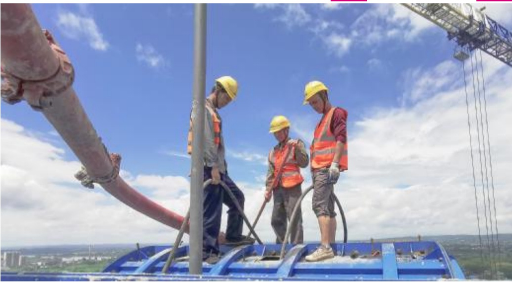
7月10日,工人在南玉铁路六景郁江特大桥首座主塔塔冠上进行封顶作业。当日,由中铁十一局承建的南宁至玉林铁路六景郁江特大桥首座主塔顺利封顶。六景郁江特大桥全长11.465公里,主跨320米,本次顺利封顶的主塔总高度123米。南玉铁路设计时速350公里,是南深铁路的重要组成部分。新华社记者张爰林摄
