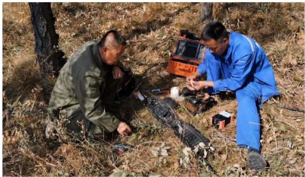
近日,根河森工公司信息中心组织专业技术人员将市区原有的电缆通信设备升级为光纤通信系统,提高了通信质量,为森林防火提供保障。 ■刘任生 摄
