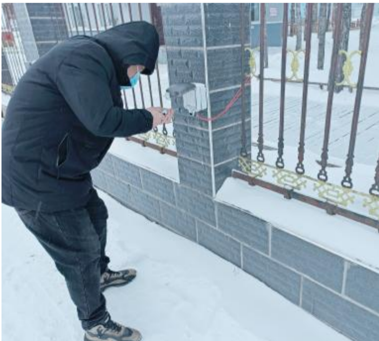
为深入践行“我为群众办实事”实践活动,日前,图里河酒业有限责任公司组织安全部门的工作人员在车棚安装了5个临时充电器,有效解决职工电瓶车冬季充电难的问题。
