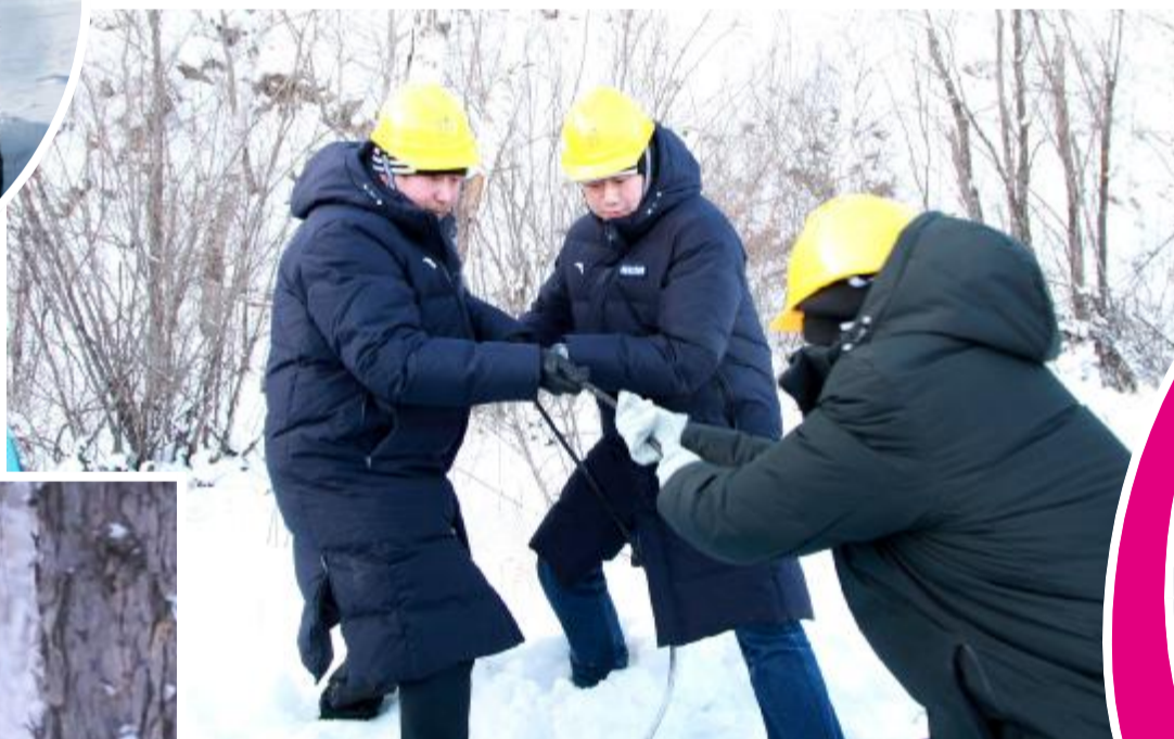
通信抢修演练现场
