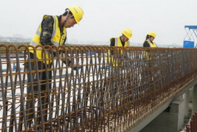
4月25日,中铁二十局建设者在苏台高速公路七都至桃源段ST-QL5标施工现场绑扎钢筋。眼下,由中铁二十局承建的苏州至台州高速公路七都至桃源段ST-QL5标建设有序推进。该标段全长约4公里,主要工程为主线桥梁2座,互通匝道桥梁3座,地面桥梁4座。目前,项目正在进行桥梁基础及下部结构施工、预制箱梁生产架梁等。新华社记者 季春鹏 摄
