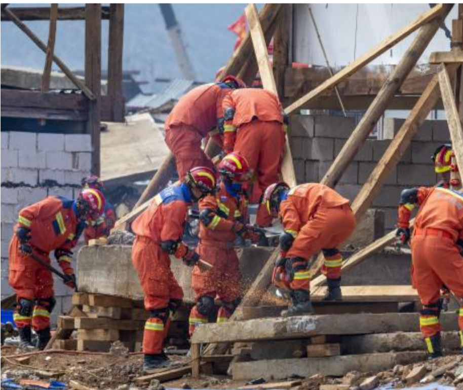
5月16日,参演人员在丽江演出现场对受损建筑物进行排除加固。
