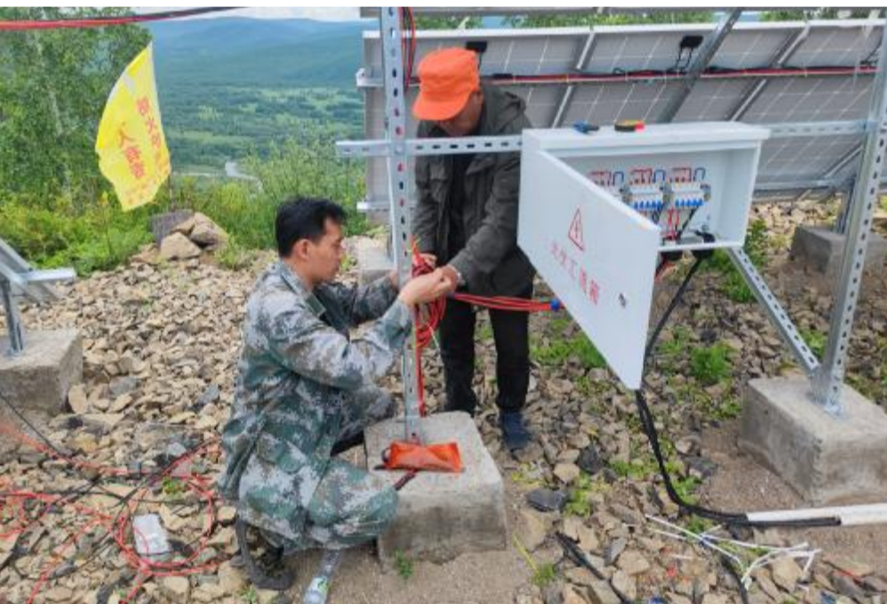
近日，图里河森工公司信息中心完成了沙河义防火瞭望塔和大秃山防火瞭望塔通信基站建设，提高了生态功能区内的网络覆盖率，提升了应急通信保障水平，不断为生态保护工作提供通信保障。 ■ 李东 高小军 摄
