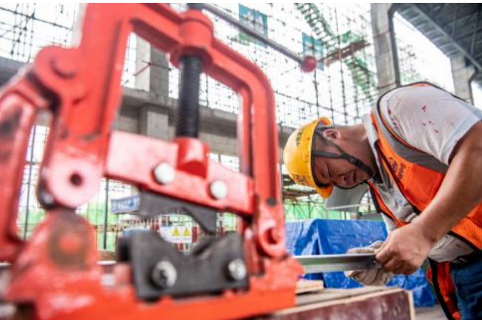
9月20日,工作人员在江津北站建设现场施工作业。 目前,包括江津北站、永川南站在内的渝昆高铁川渝段站房项目主体结构全部完成。渝昆高铁川渝段正线全长约292公里,全线共设9个车站。渝昆高铁是全国铁路网“八纵八横”主通道之一的京昆通道的重要组成部分,设计时速350公里。 新华社记者 唐奕 摄
