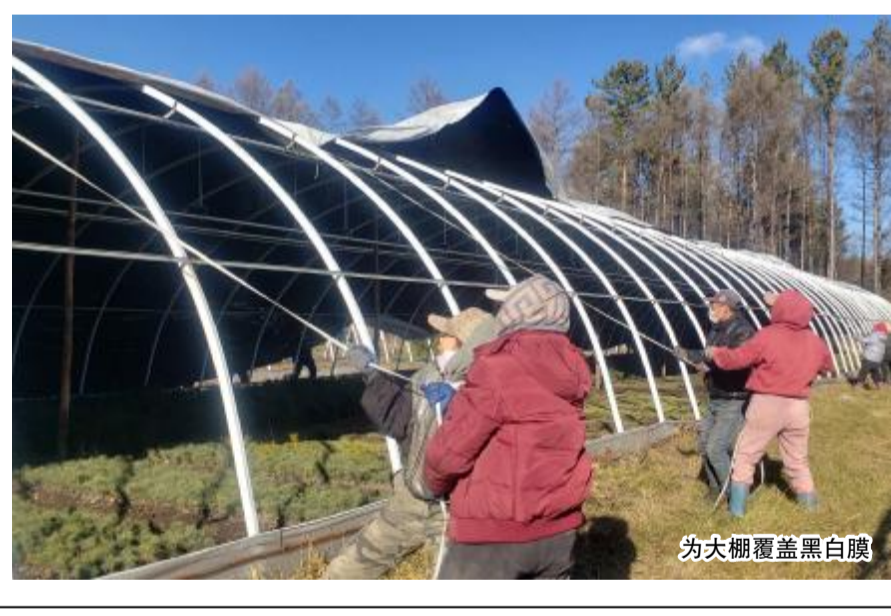
为苗木铺盖干草防寒
